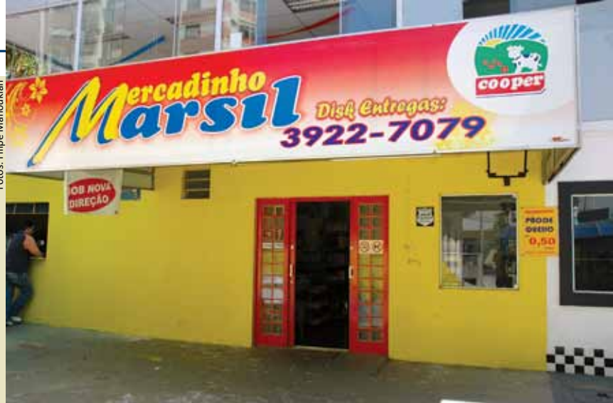
O novo ponto de venda funciona na Rua Santa Clara
